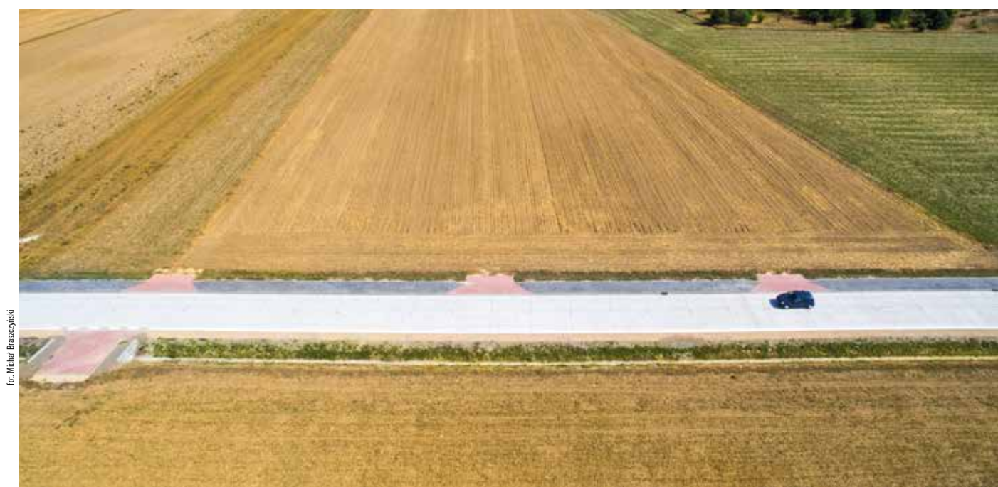
Droga powiatowa Otmice – Izbicko wykonana w nawierzchni betonowej – 2015 r.
