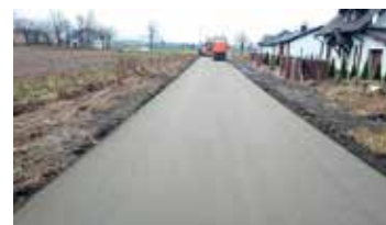
Kolejne etapy budowy w technologii RCC ul. Kubusia Puchatka w Mogilnie k. Gniezna (fot. LafargeHolcim)
