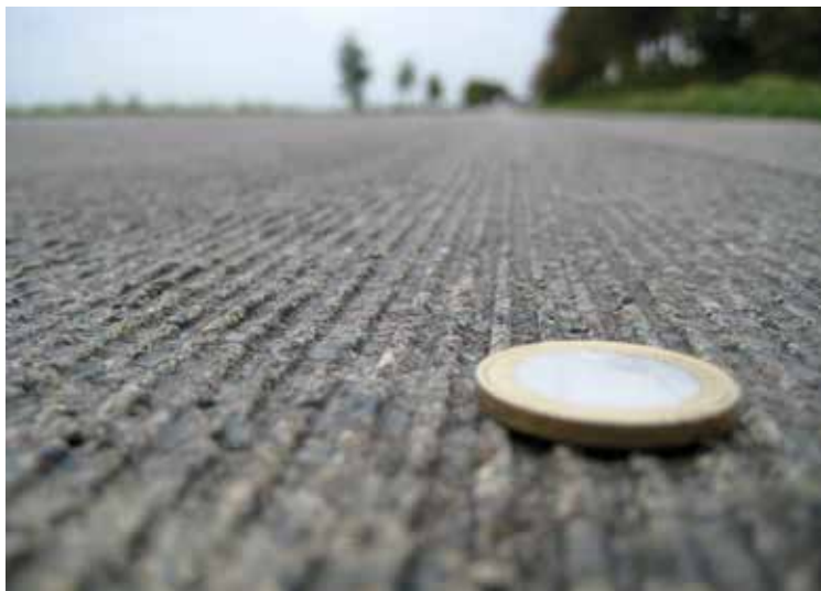
Rys. 6. Efekt mikrofrezowania na powierzchni betonu [źródło: www.bik-stroy.ru ]
