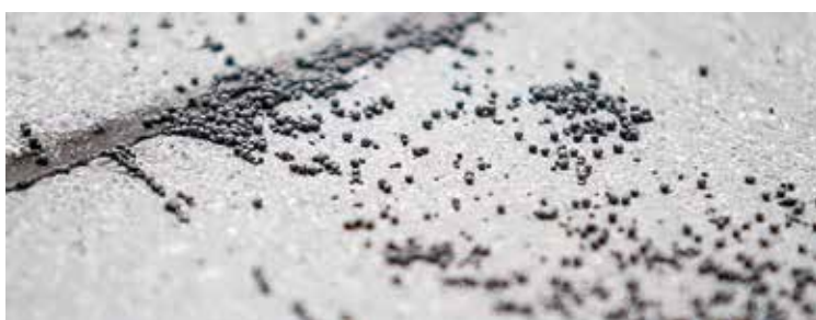
Rys. 4. Tekstura uzyskana poprzez śrutowanie powierzchni betonu [źródło: www.obrobka-betonu.pl ]
